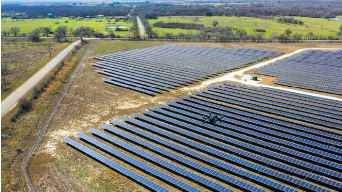
Inspection par drone d'une ferme solaire.
